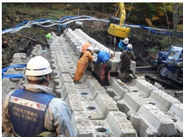
写真 4.3.3 ブロック堰堤工の事例（御嶽山）
