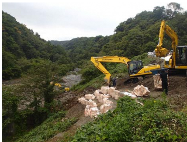
写真 4.3.2 仮設道路設置の事例 (御嶽山)
