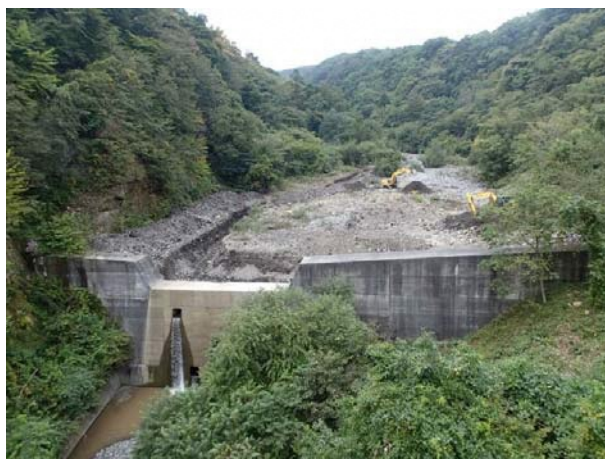
写真 4.3.1 除石工の事例 (御嶽山)
