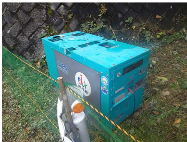
写真 5.2.1 監視カメラ設置時の発電機の例（御嶽山）
