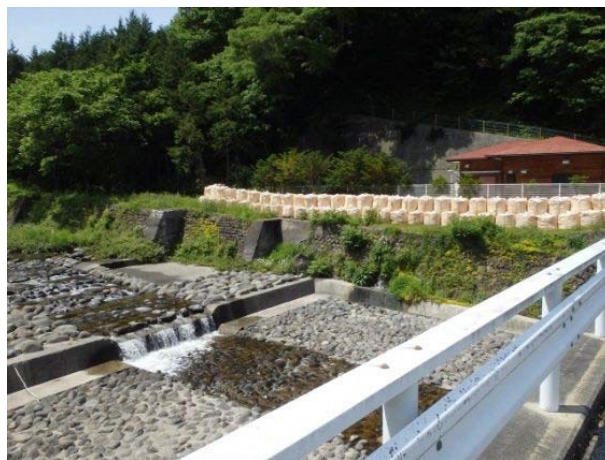
写真 4.3.4 導流堤工の設置事例 (御嶽山)
